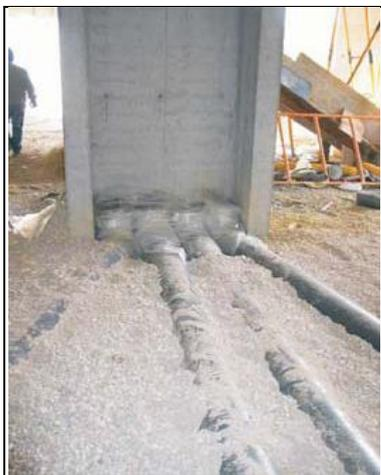
Figura 6.19 – Conexão das tubagens às coretes (LNEG, 2012)
