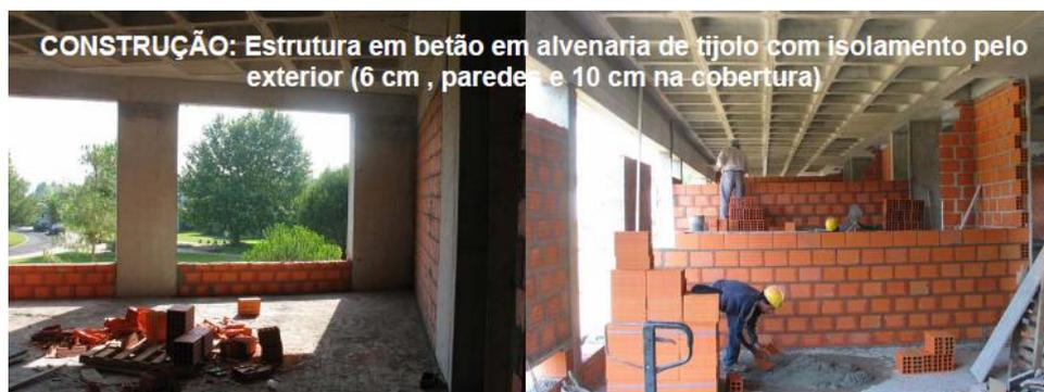
Figura 6.5 – Construção dos panos de alvenaria do edifício (IEFP, 2012)
