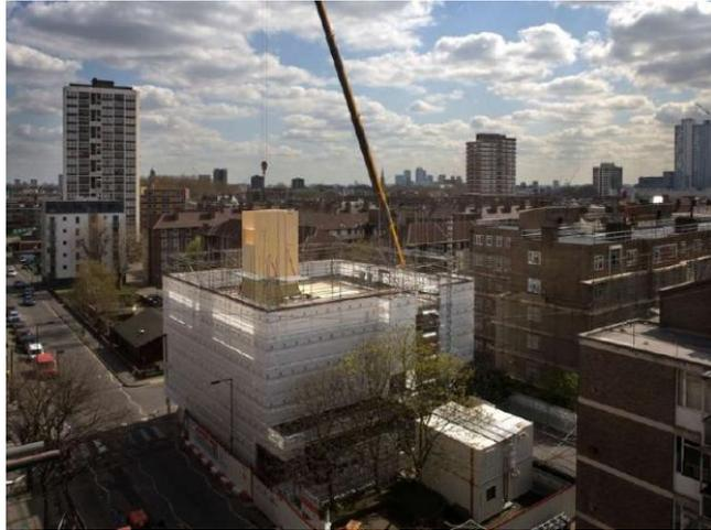
Figura 6.30 – Construção do edifício com recurso a guindastre móvel (TRADA, 2009)
