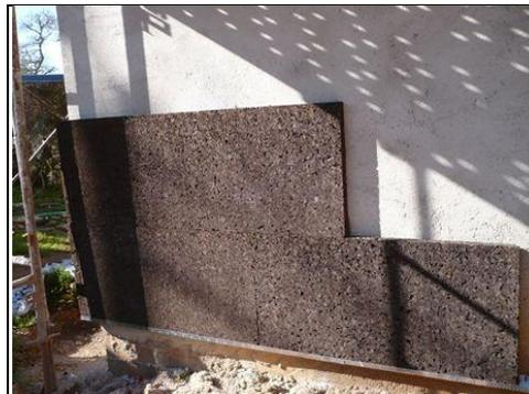
Figura 5.8 – Placas ICB (Gil,1998) Figura 5.9 – Aplicação como isolante térmico exterior(Gil,1998)
