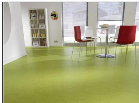
Figura 5.6 – Aplicação de painéis de linóleo em pavimento (Gil,1998)
