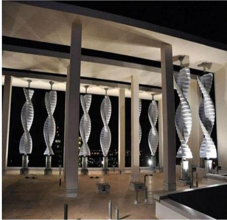
Figura 3.8 – Turbinas eólicas da cobertura (Singh, 2012)
