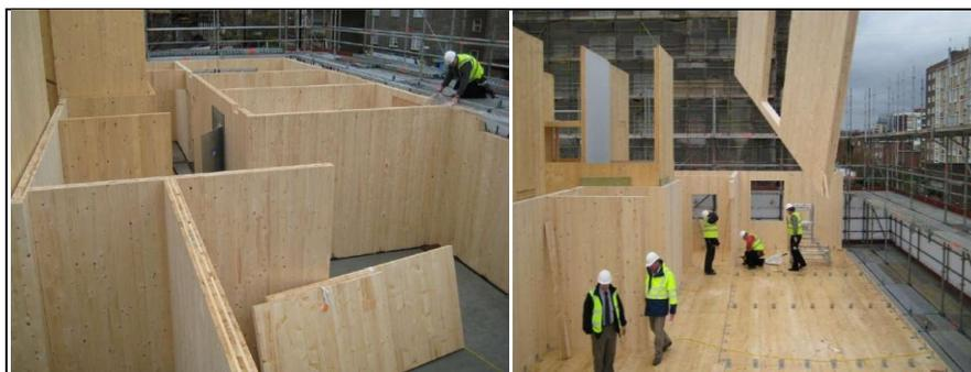
Figura 6.27 – Assemblagem dos painéis CLT durante a obra (LIDDELL, 2013)
