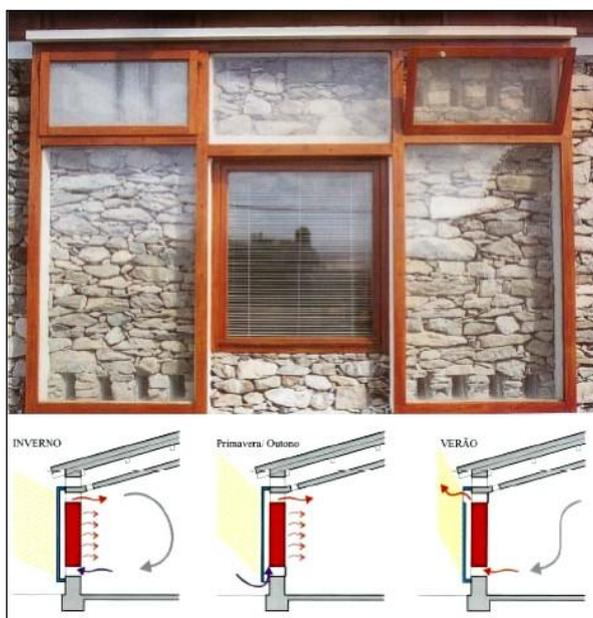
Figura 2.3 – Parede de trombe ventilada e esquema do seu funcionamento (Gonçalves e Mariz, 2004)
