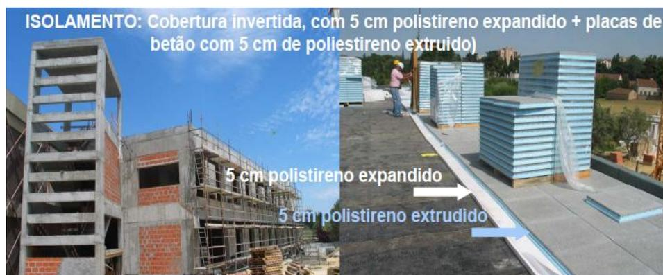
Figura 6.6 – Colocação do isolamento térmico na cobertura do edifício (IEFP, 2012)
