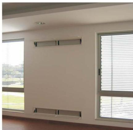
Figura 6.12 – Interior da parede de trombe (LNEG, 2012)
