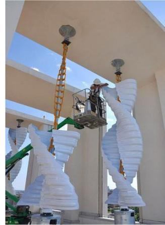
Figura 3.9 – Instalação das turbinas (Singh, 2012)
