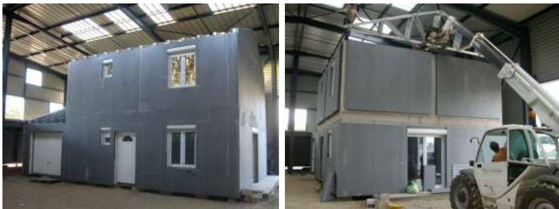
Figura 4.5: Sistema em painéis de aço galvanizado – fase de montagem em fábrica.
