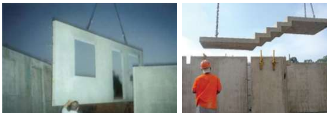
Figura 4.2: Sistema de grandes painéis pré-fabricados em betão – fase de construção. Fonte: César Melo, 2004
