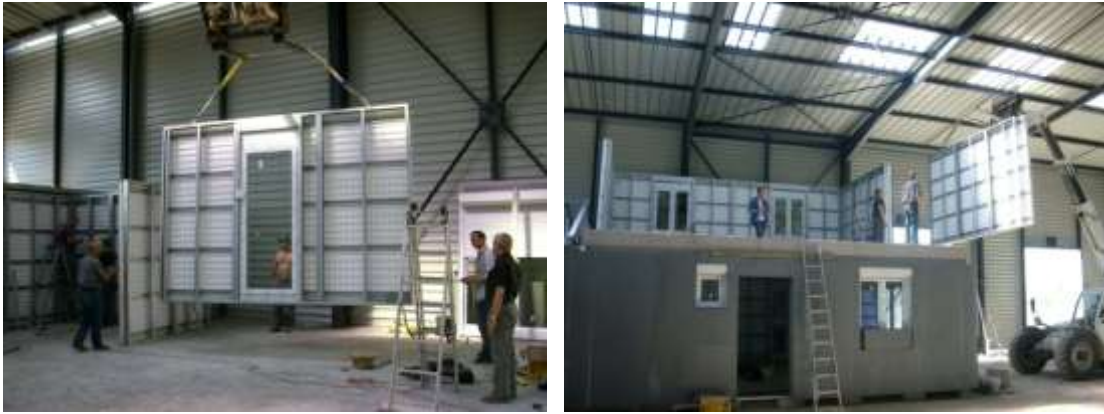
Figura 4.4: Sistema em painéis de aço galvanizado – fase de montagem em fábrica.
