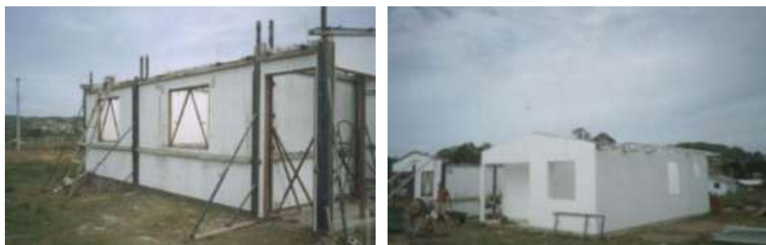
Figura 4.6: Sistema em painéis de PVC – fase de construção. Fonte: César Melo, 2004
