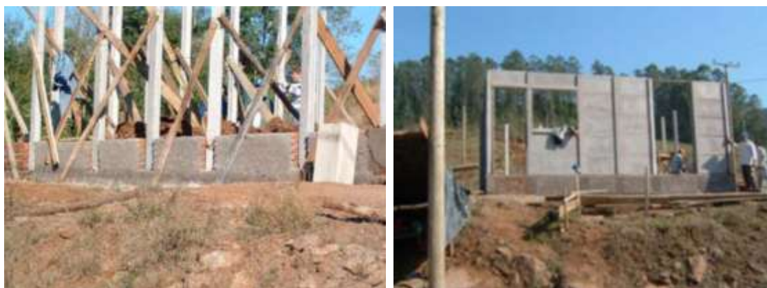
Figura 4.1: Sistema pré-fabricado em betão – fase de construção. Fonte: César Melo, 2004
