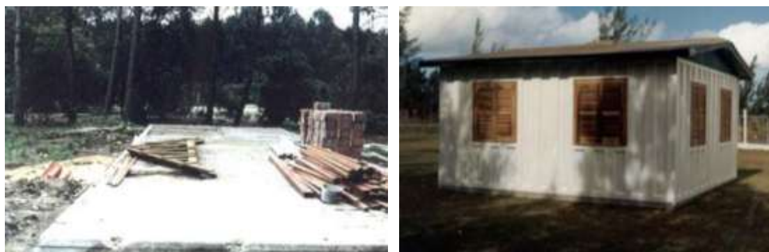
Figura 4.3: Sistema em painéis de fibra de vidro – fase de construção e obra concluída. Fonte: César Melo, 2004
