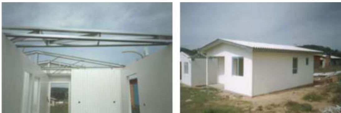
Figura 4.7: Sistema em painéis de PVC – fase de montagem da cobertura e obra pronta. Fonte: César Melo, 2004
