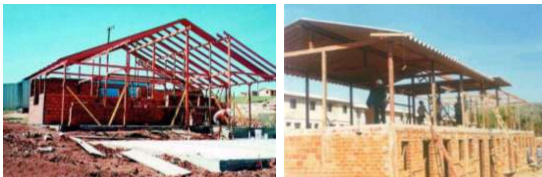
Figura 4.8: Sistema alvenaria e estrutura metálica – fase de construção. Fonte: César Melo, 2004
