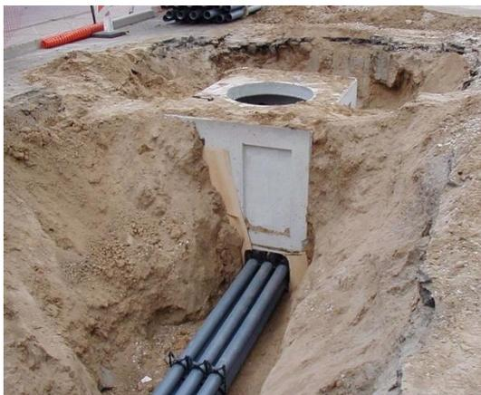
*Figura 38 – Fotografia de uma vala técnica com a interligação de tubagens numa caixa de visita*
