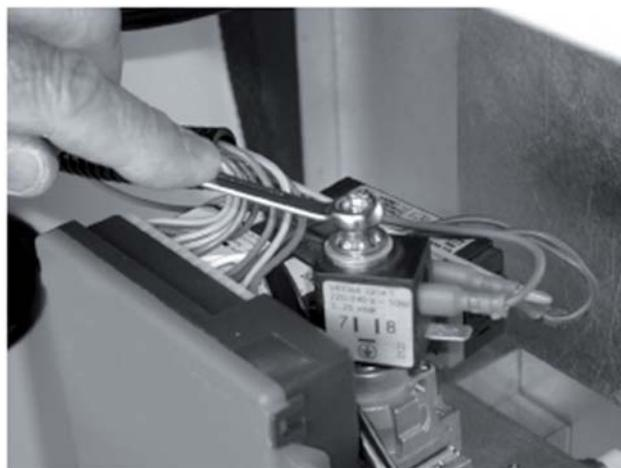
Verifique e regule, caso necessário, a pressão de saída da válvula para 8,4 mbar (G20) / 12,3 mbar para Groningue (G25) e 31,4 mbar para propano (G31).
