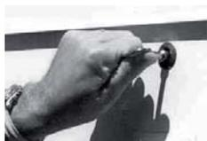
Após a entrega, recomenda-se que a chave que se encontra presa a uma anilha seja guardada num local seguro e acessível. Esta permitirá a abertura dos painéis para realizar trabalhos de manutenção e instalação. As fechaduras são de ¼ de volta e, em seguida, apertam.
