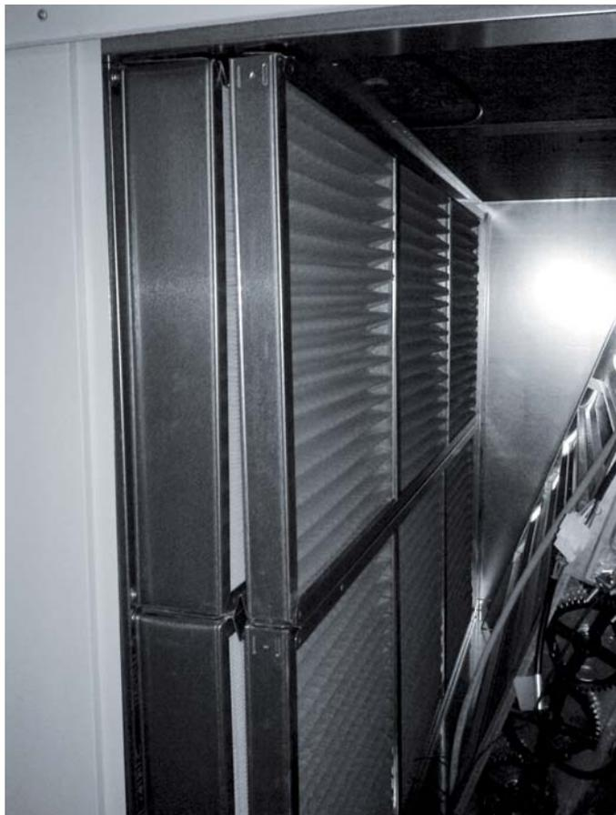
O controlador CLIMATIC™ 60 pode monitorizar a perda de carga na secção de filtragem.
