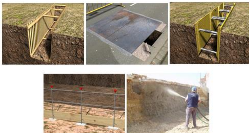
Fig. 3. 12 - Prevenção em Trabalhos de Escavação [21]
