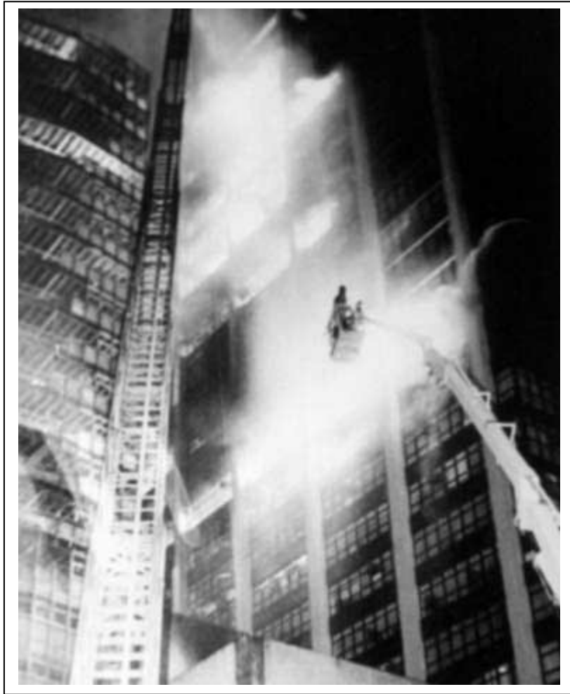
Figura 07 - Outro exemplo de combate a incêndio externo
