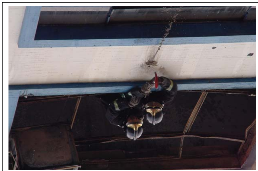
Figura 20 - Bombeiros fazendo abertura para escoamento d'água
