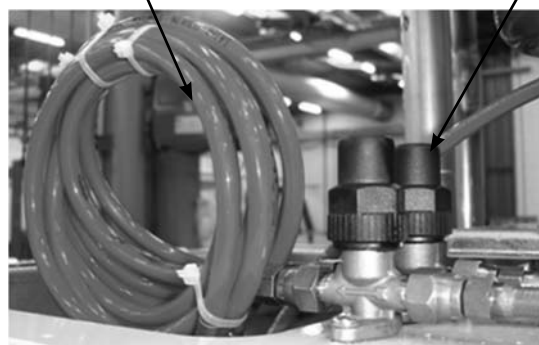
Tubos de alta pressão prontos para serem ligados à válvula
