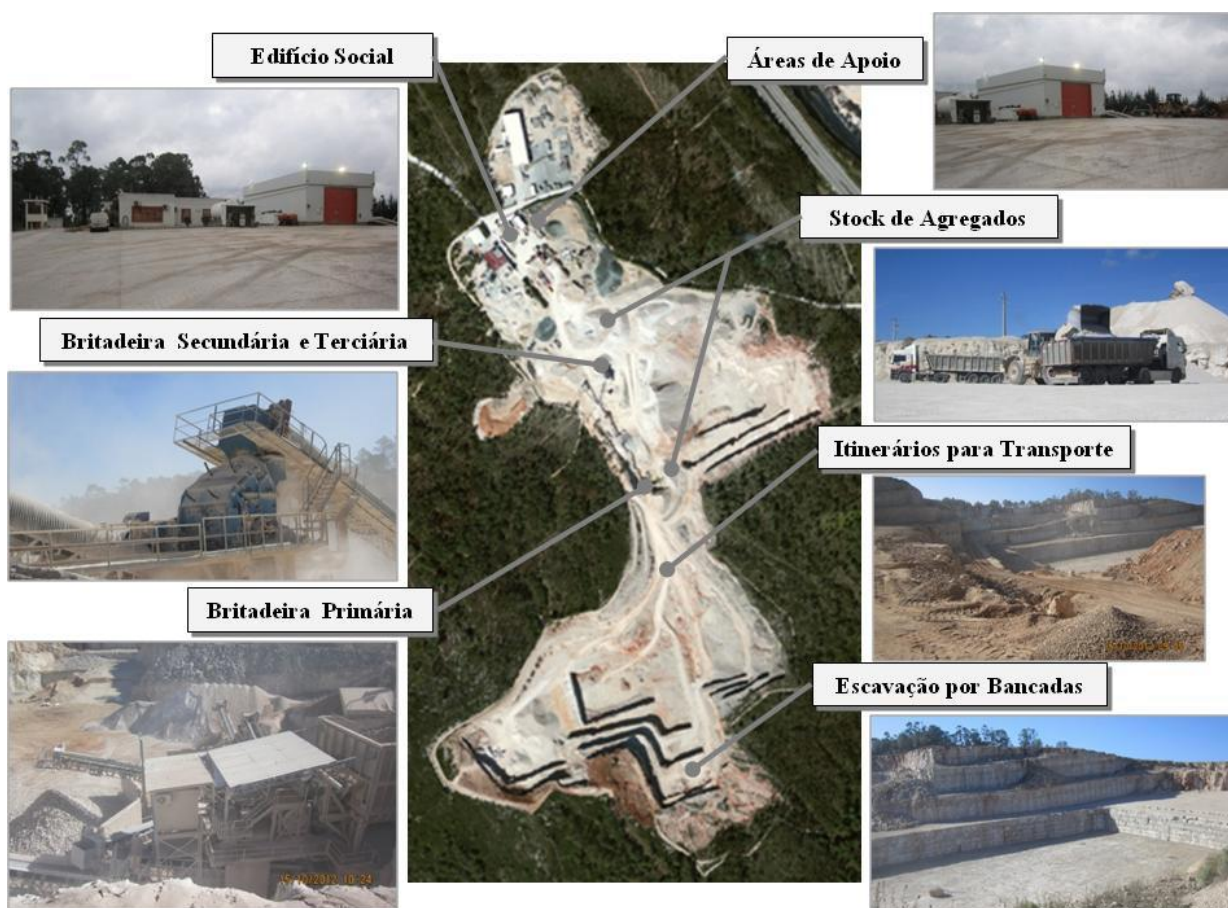
Figura 16. Vista de satélite da exploração a céu aberto. Fonte: Autor (fotos) e http://www.geoportal.lneg.pt , acedido em 31/01/2013.
