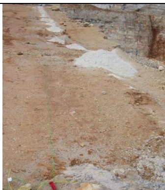
Figura 45. Malha de furos (plano de desmorte)
