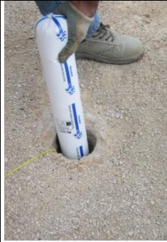
Figura 29. Carga dos furos com explosivos
