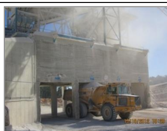
Figura 37. Descarga e transporte interno dos agregados
