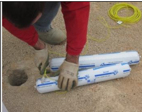
Figura 49. Colocação do detonador no explosivo de fundo
