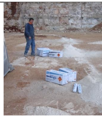
Figura 47. Distribuição dos explosivos (plano de furação)
