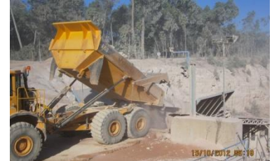
Figura 33. Descarga na tremonha da britadeira
