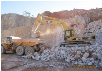
Figura 31. Carga dos dumpers
