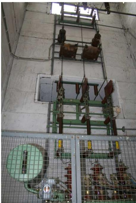
**Figura 5.18** – Barramento MT no posto de transformação (PT).
