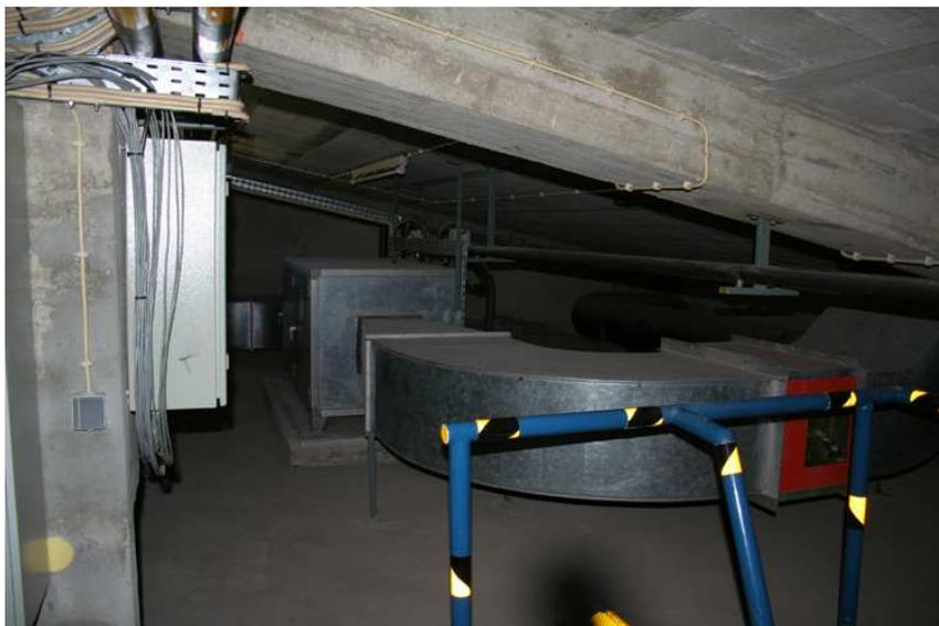
**Figura 5.2** – Uma das unidades de tratamento de ar (UTA) localizada no edifício do Engenharias I.
