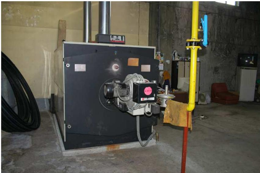
**Figura 5.1** – Uma das três caldeiras que fazem parte da central térmica.
