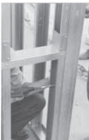
Foto 3.7 - Bloqueador e fita de aço galvanizado fixados ao painel para travamento horizontal
