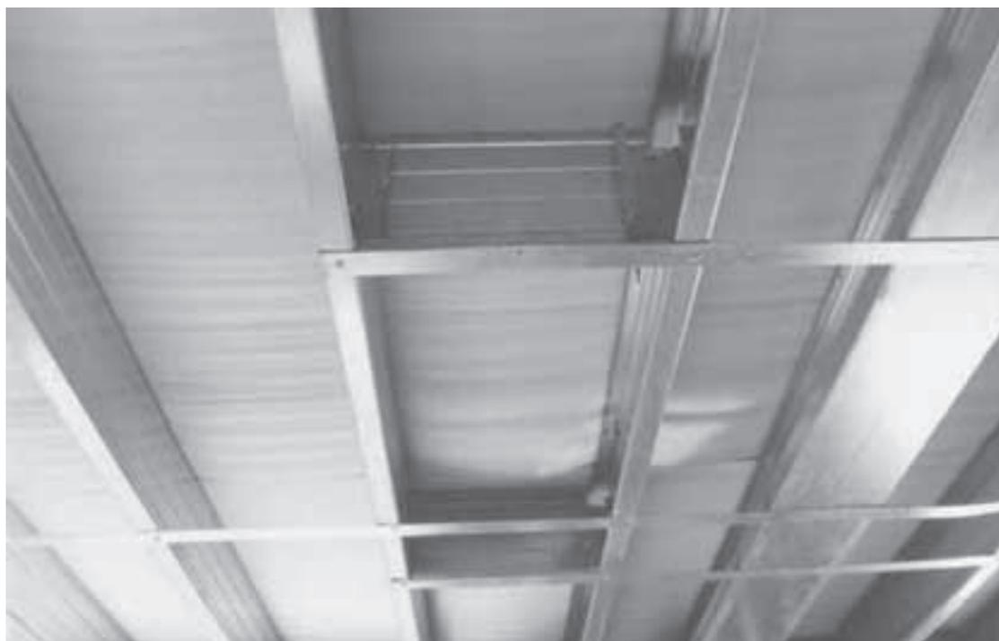
Foto 4.8 - Travamento horizontal da laje de piso por meio de bloqueadores e fitas metálicas
