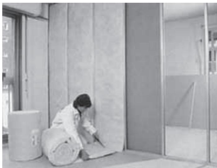
Foto 6.7 - Isolamento termoacústico (Fonte: Isover)
