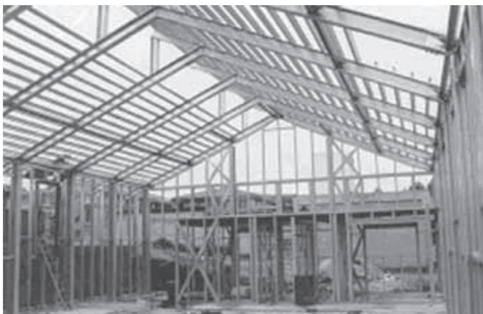
Foto 5.2 - Telhado estruturado com caibros em um laboratório na Universidade Federal de Ouro Preto - MG (Fonte: Arquivo Célio Firmo)
