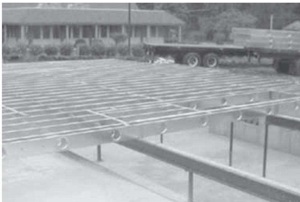
Foto 4.7 - Vigas de piso apoiadas sobre viga principal em aço (Fonte: <http://www.aegismetallframing.com>)
