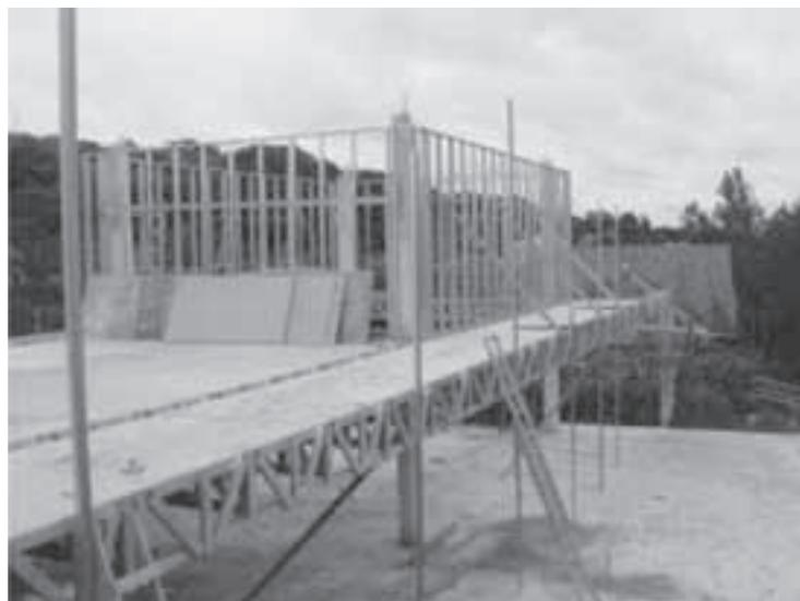
Foto 4.4 - Painéis **Masterboard** utilizados para laje seca (Fonte: Flasan)
