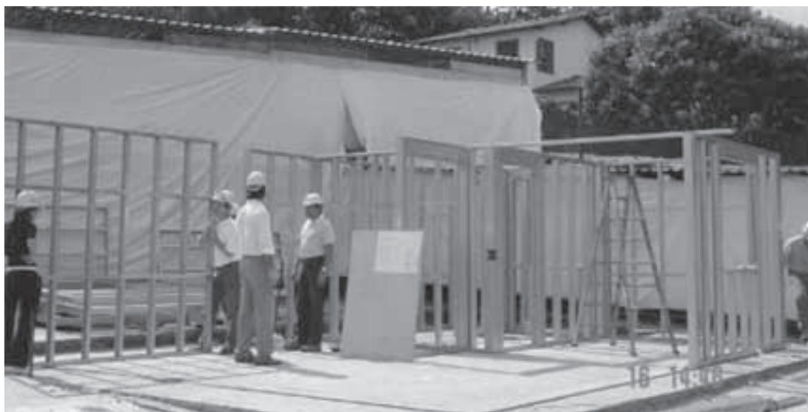
Foto 2.10 - Elementos estruturais como tesouras e painéis são pré-fabricados em oficinas e levados à obra para montagem da estrutura (Fonte: <http://www.aegismetalf framing.com>).
