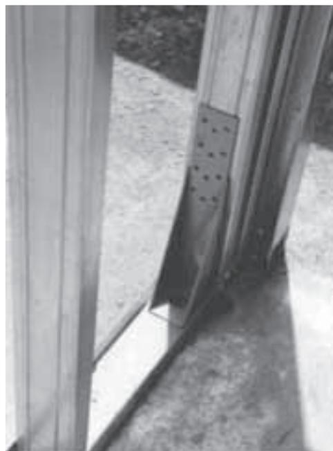
Foto 2.13 - Peça de reforço na ancoragem da estrutura à fundação por meio de barra rosçada
