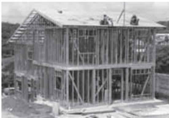
Foto 2.1 - Estrutura de residência em Light Steel Framing, São Paulo (Fonte: Construtora Sequência)
