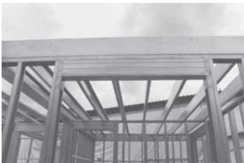
Foto 4.6 - Vigas de piso apoiadas em montantes de painéis do pavimento térreo
