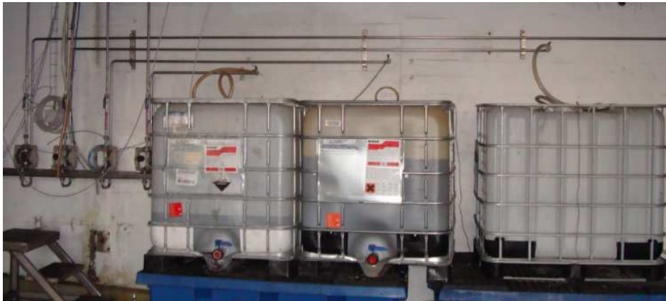
Figura 3.13 Disposição actualizada dos contentores de aditivo e de ácido – Linha 3
