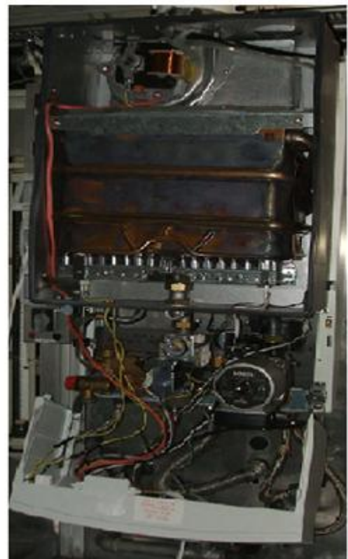
Figura 12 – Esquemático da caldeira (a); Caldeira (b)
