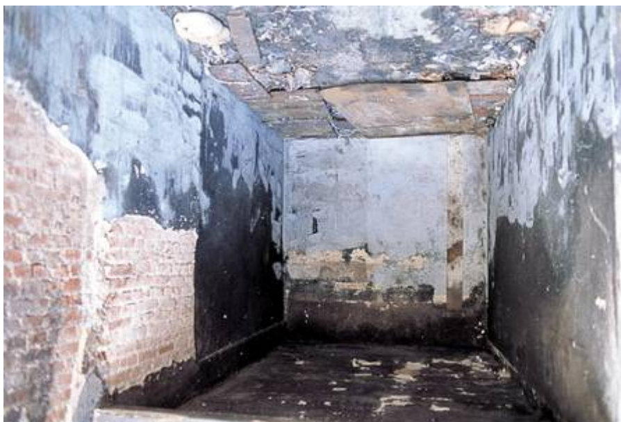
Fig 26 e 27 Trincas e deformações nas paredes e teto
