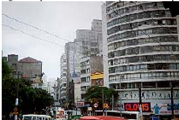
Fig. 19– A proximidade de edificações favorece a propagação do incêndio
