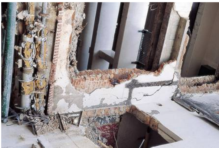
Fig 26 e 27 Trincas e deformações nas paredes e teto
