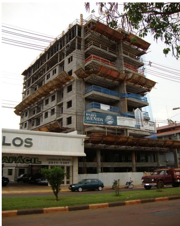
Figura 1: Plataformas de proteção
