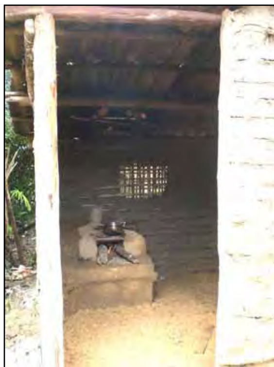
Fotografia 15 - Cozinha recém- barreada, vista interna parcial.
