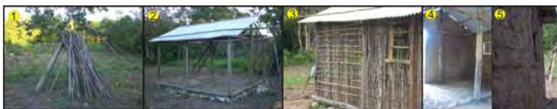
Figura 9- Etapas da Construção de Casa de Pau-a-Pique
