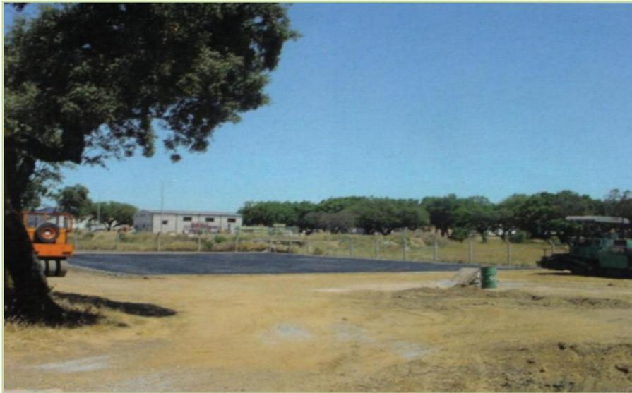
**Figura 12** Aspecto do chão impermeabilizado, onde se armazenará o composto.
