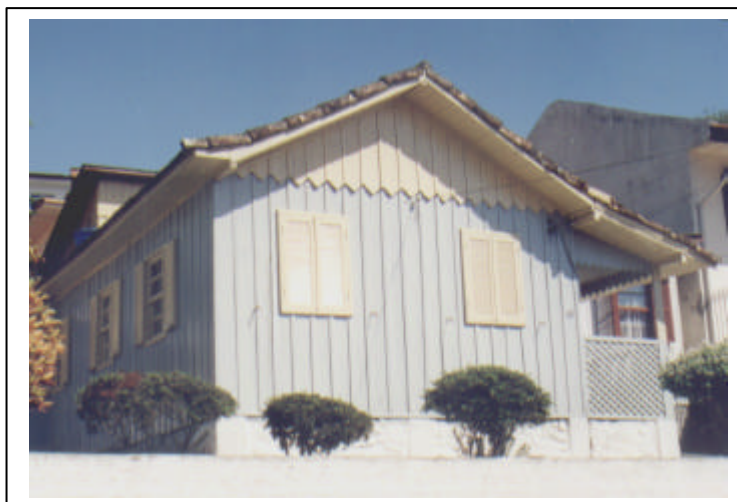
Figura 50: Casa de tábuas matajuntadas com ripas. Fonte: Autor. Florianópolis, 2001.
