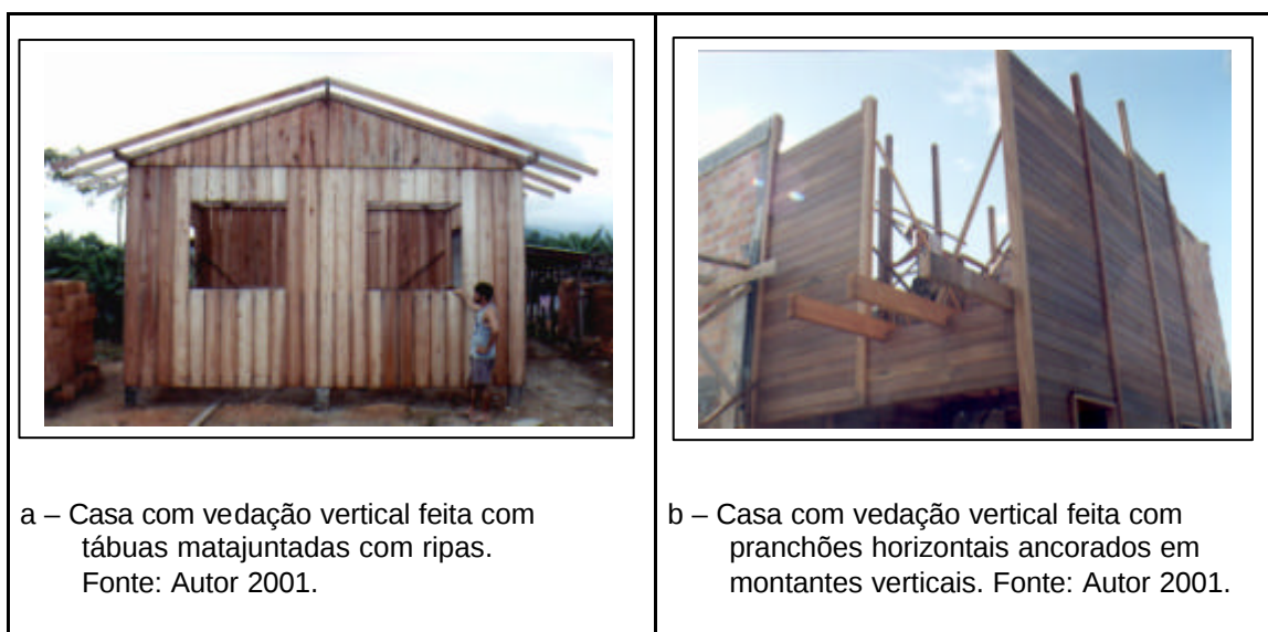
Figura 60: Aspectos gerais externos das edificações consideradas para a análise da tarefa.
