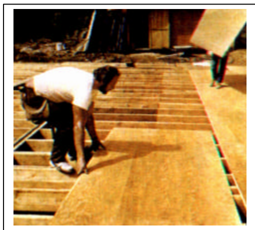
Figura 21 : Aplicação De chapas de compensado para compor piso de edificação. Fonte: DATTOMI (2001, pg.20).
