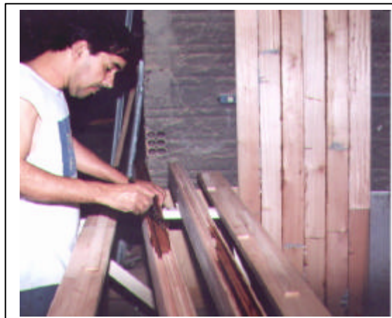
b – Aplicação da cola com pincel nas tábuas a serem emendadas lateralmente. Fonte: Autor 2001
