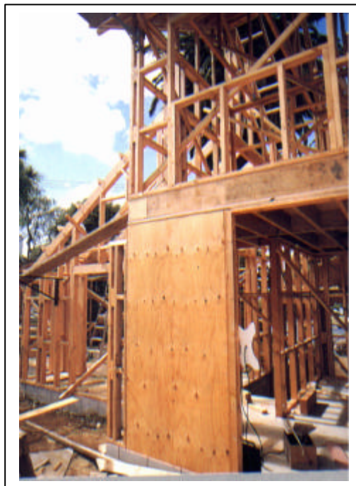
Figura 22: Aplicação de chapas de compensado para composição de vedação vertical. Fonte: "CHH PLYWOOD".(1992, pg.01).
