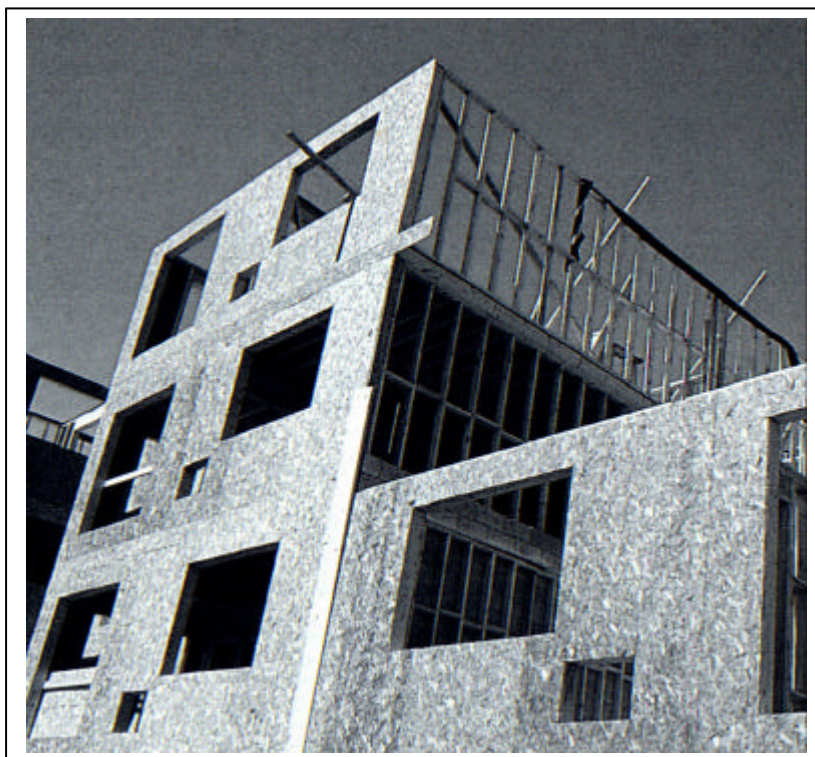
Figura 15: Aplicação de chapas de OSB para fechamento de estrutura do tipo “frame”.
