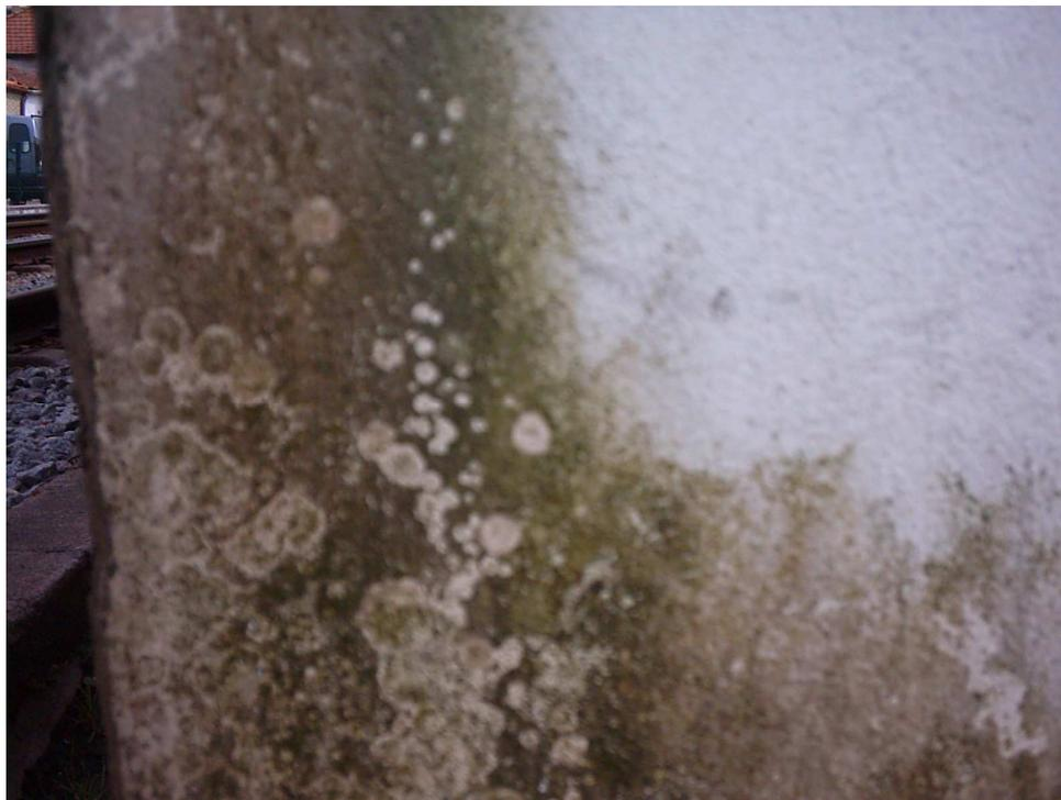
Fig.46 - Fungos ou algas em Parede Exterior 1 cm
