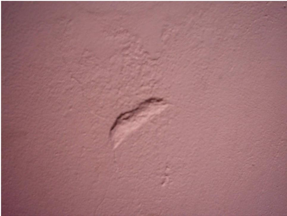
Fig.48 – Fenda provocada por colisão de “veículo” pintada posteriormente 1 cm
