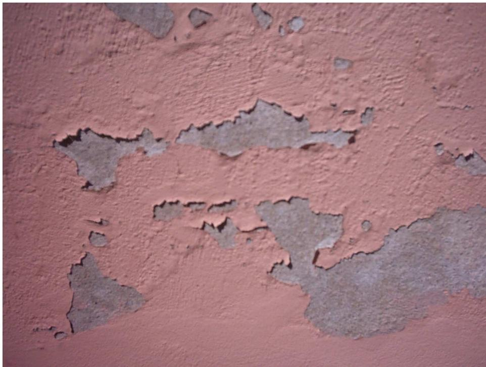
Fig.39 - Perda de Aderência do revestimento
