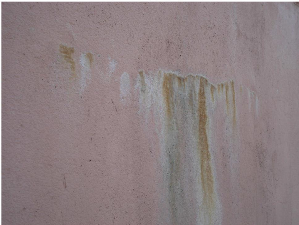
Fig.42 – Eflorescência em Revestimento Exterior 1 cm
