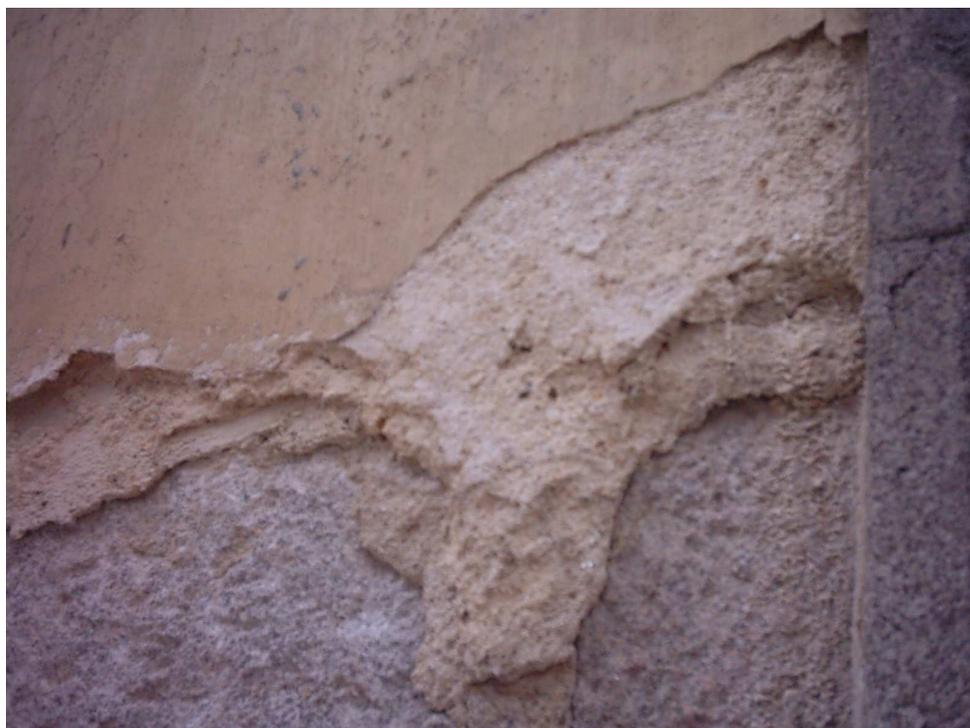
Fig.38 – Desagregação do revestimento em reboco e pintura 1cm
