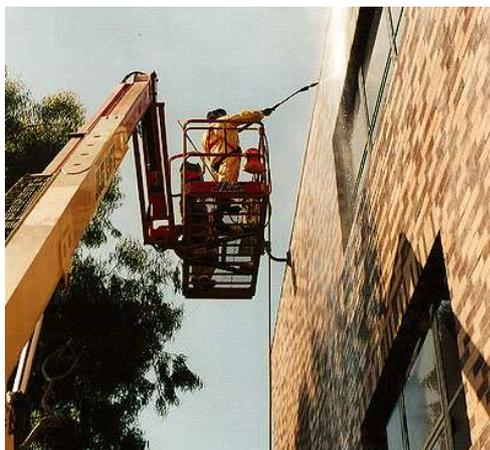
Fig.14 – Remoção de eflorescências no revestimento exterior
