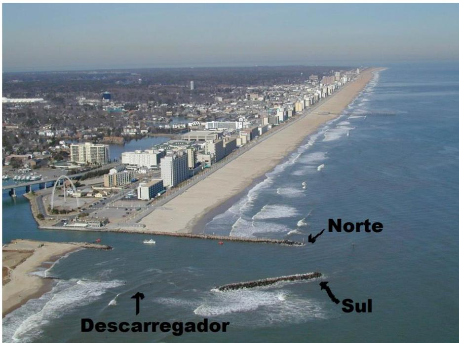
Figura 3.10. – Descarregador instalado num quebramar com deriva de Sul para Norte em Rudee Inlet, VA (<http://chl.erdc.usace.army.mil>)
