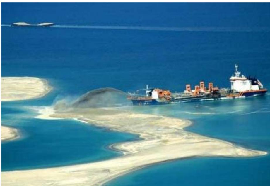
**Figura 3.7.** – Draga a efectuar o descarregamento de areias em forma de arco-íris (www.gulfnews.com)
