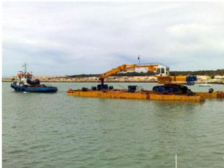
Figura 3.6. – Dragagem mecânica assente numa barcaça auxiliada por uma pequena embarcação (www.dredgebrokers.com)
