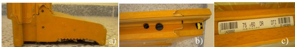
Figura 23: Base de apoio da janela, a); união dos perfis, b); etiqueta que acompanha a janela, c)
