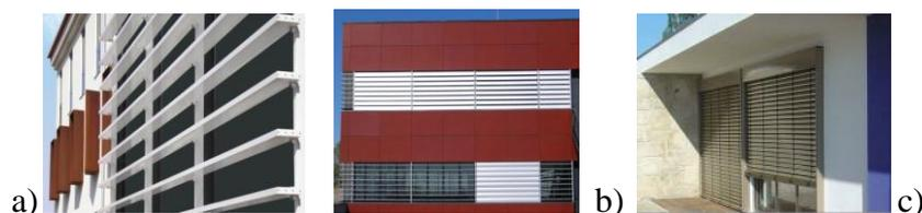
Figura 46: Lamelas de sombreamento fixas, a); reguláveis, b) e Brisa solar, c)
