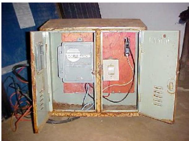
**Foto 5 – Paraíba: Equipamento desativado por falta de manutenção**
