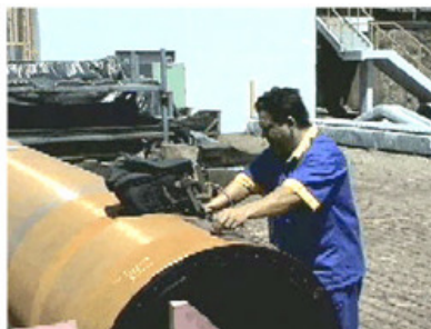
Figura 8. Inspeção por ultra-som da chapa de um tubo
