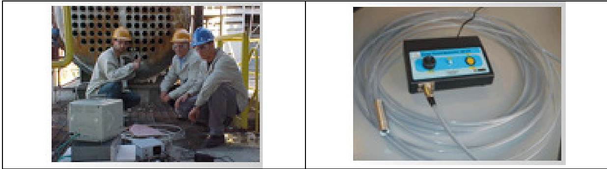
Figura 3. Fotos de uma inspeção de caldeira utilizando uma sonda.
