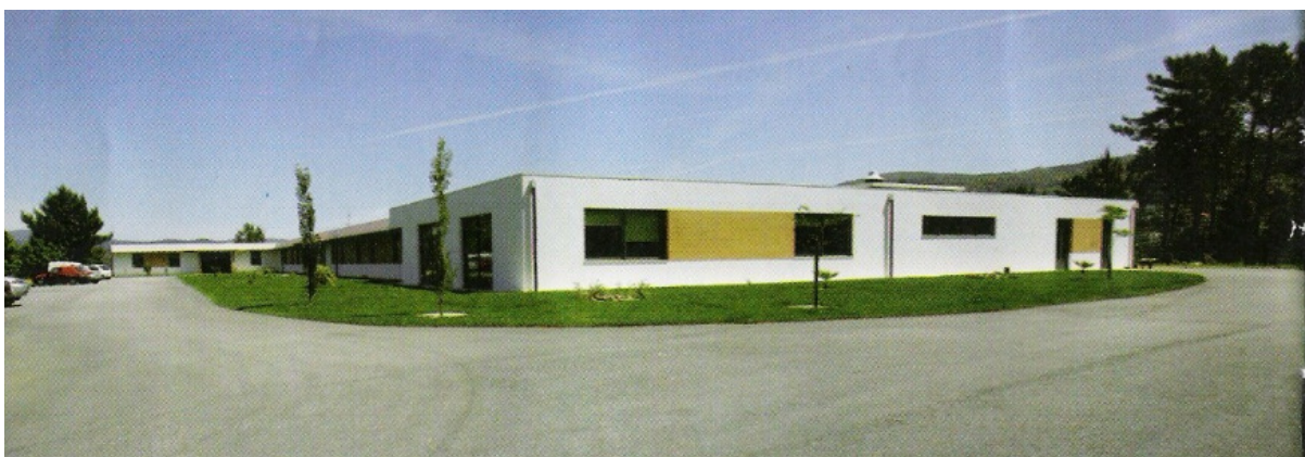
Fig.5.1 – Edifício do lar de idosos.
