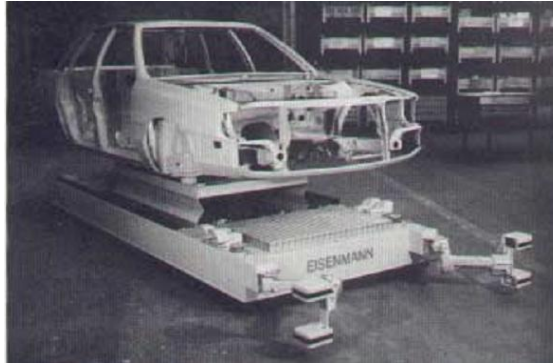
Figura 6 - AGV Carregando um Chassi (FERREIRA 1998)
