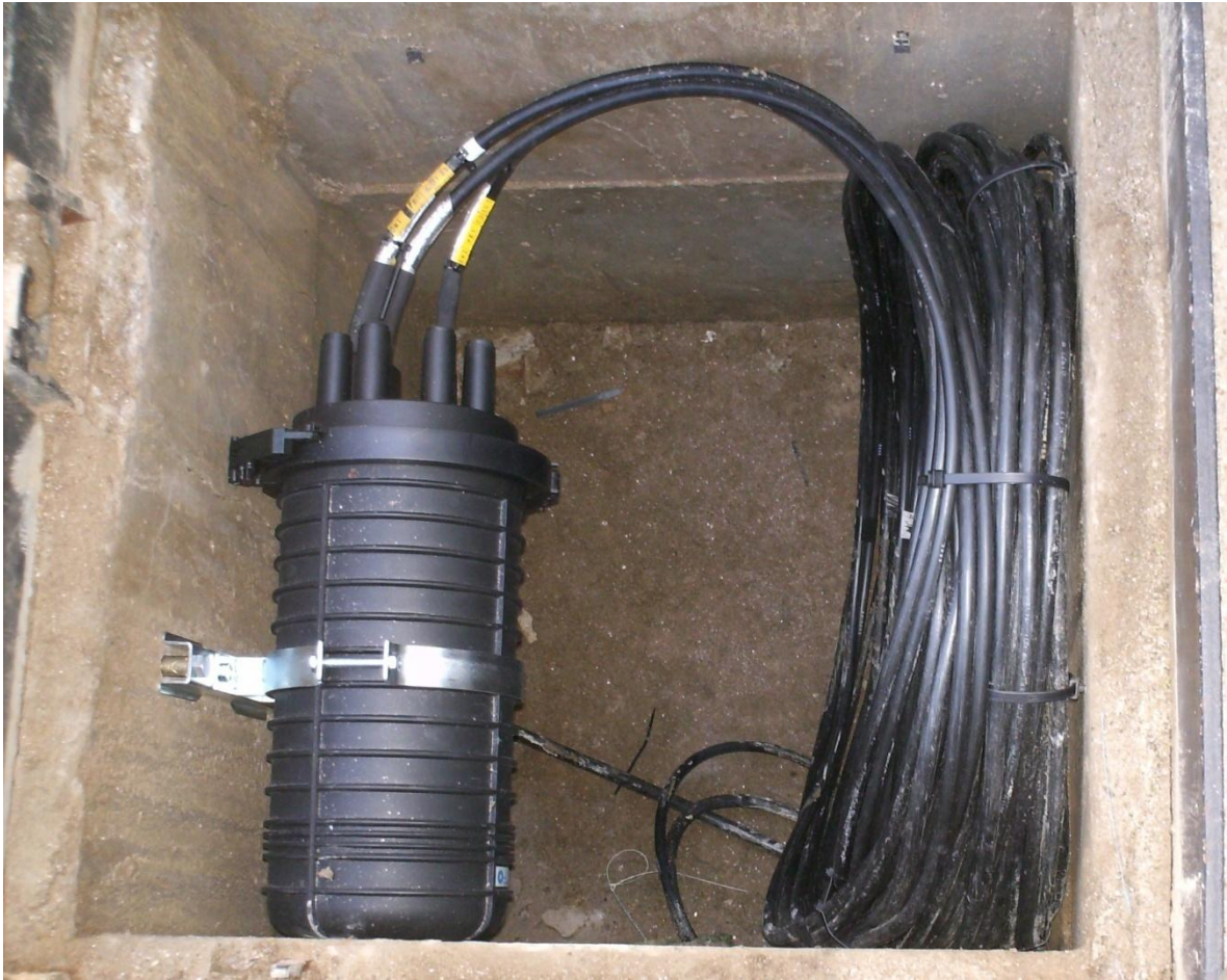
Figura 38 – Fotografia exemplo da instalação de uma junta de fibras ópticas do tipo torpedo, no interior de uma caixa do tipo CVR1
