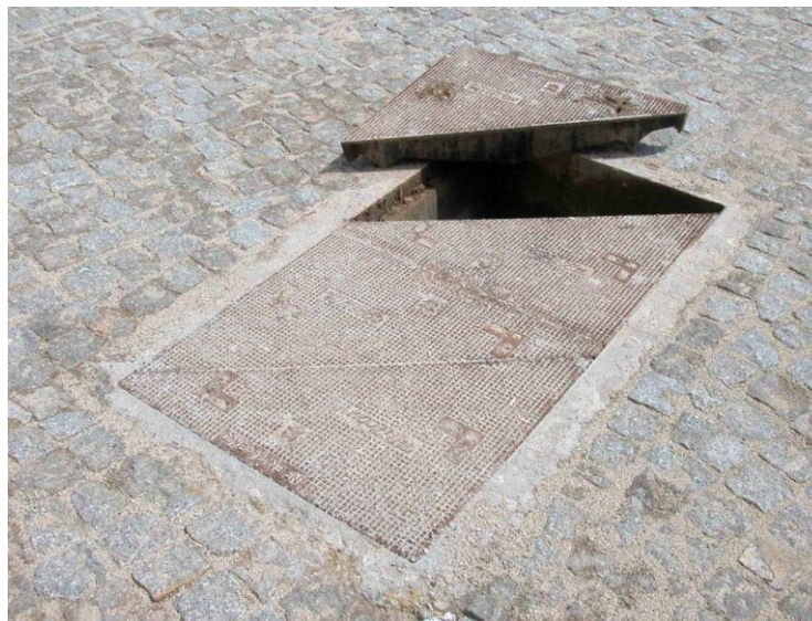
Figura 26 – Exemplo de Tampa de câmara de visita do tipo CVR2
