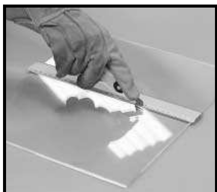
Figura 4. Demonstração do risco na chapa.
