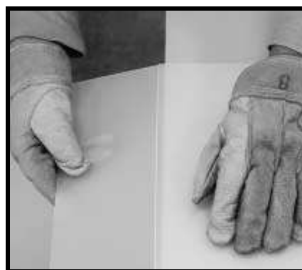
Figura 5. Separação da parte riscada.
