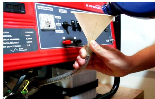
**2 -** Retirar a vareta de nível de óleo. Com o auxílio de um funil e uma mangueira, abastecer o cárter com óleo para motores a gasolina.
