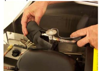
*Retire o isolamento da válvula e da tubulação adjacente.*
