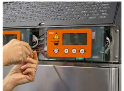
Retire os quatro parafusos de montagem do painel de Plexiglas.
