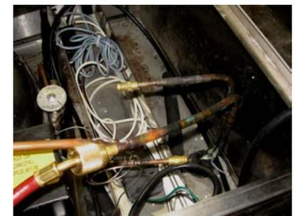
*Pressurize o lado baixo a 250 PSIG (17,2 Bars) usando nitrogênio, verifique se há fugas e o nível de pressão depois de 10 minutos e outra vez depois de 24 horas.*
