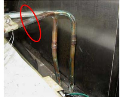
*Separe e corte as linhas laterais alta e baixa do evaporador (parede fria) e solde nas conexões de acesso.*
