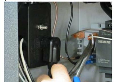
Use um alicate para retirar a conexão de 24 volt e os terminais do contator.
