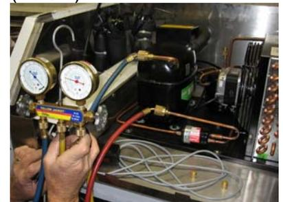
Verifique as pressões da Válvula de Sucção e da de Descarga usando um medidor de refrigeração.
