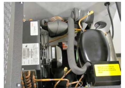
Aceda ao motor da ventoinha do condensador da abertura superior do compartimento.
