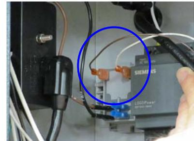
O relé está montado à esquerda de dois fornecedores de energia de 24 volt no trilho DIN.
