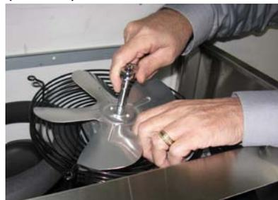
Retire a lâmina da ventoinha do eixo do motor usando uma chave de porca ou de encaixe de 5/16" (8 mm).
