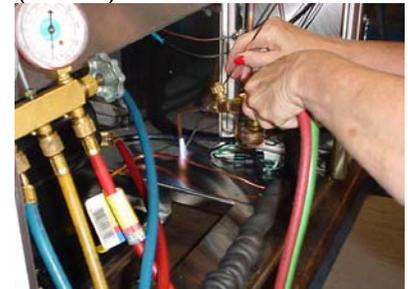
*Quando vede o sistema ou repare fugas, use uma carga contínua de Nitrogênio para manter os contaminantes fora.*
