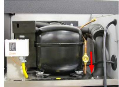
Retire os quatro parafusos de montagem da base do Conjunto do Condensador.
