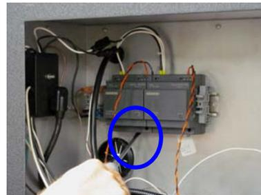
*Use uma chave de fenda para pressionar o espaçador para baixo da caixa da base do fornecedor de energia, para soltá-lo do trilho de montagem DNI.*
