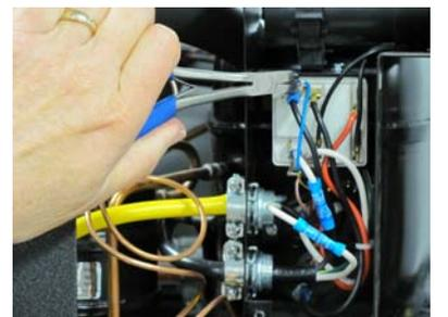
Retire os três fios do motor da ventoinha dos terminais do relé.
