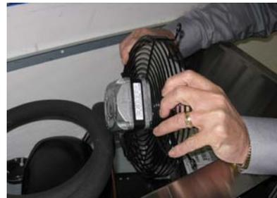
Retire o conjunto motor/ventoinha da carcaça do condensador.
