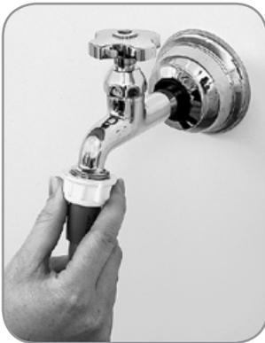
9. Rosqueie a mangueira de entrada de água na torneira, aperte o suficiente para não haver vazamento. Abra a torneira. Caso ocorra vazamento, reaperte as conexões.
