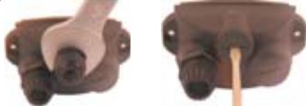
12° Com todos os cabos preparados, insira a porca dos prensa cabos e a borracha de vedação nos cabos que serão utilizados.
