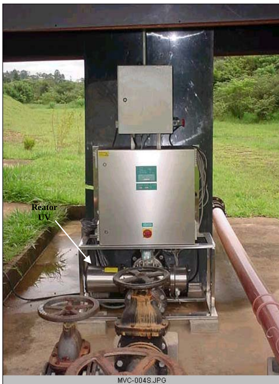
Figura 1 – Vista geral da unidade UV
