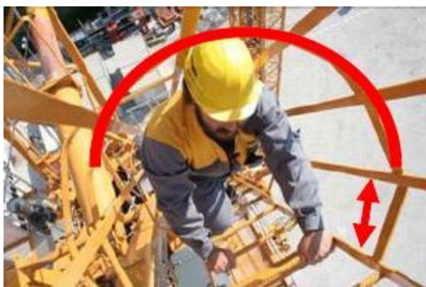
Figura 35: Protecção de escada da torre de acesso à cabine (Liebherr, 2012)
