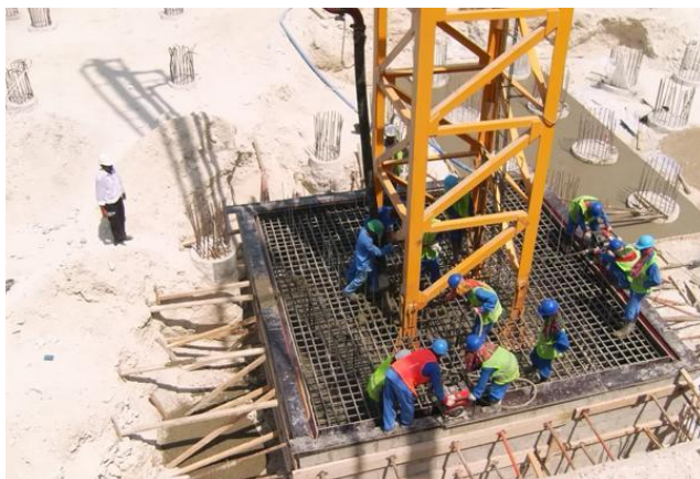
Figura 27: Execução de uma sapata de betão armado para a fundação de uma grua torre
