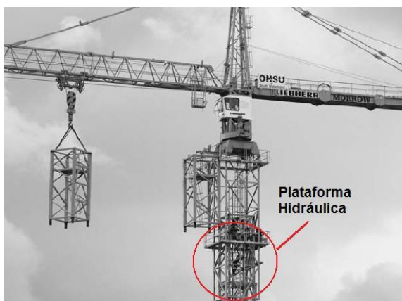
Figura 30: Sistema auto-icável externo (Adaptado de Shapiro, et al., 2011)
