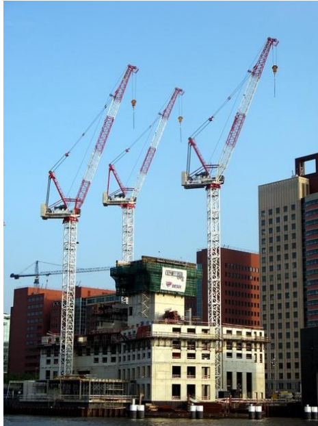
Figura 21: Grua torre de lança inclinável (Liebherr, 2012)
