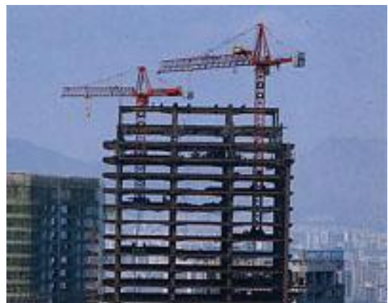
Figura 31: Sistema auto-icável interno (DEYING, 2012)
