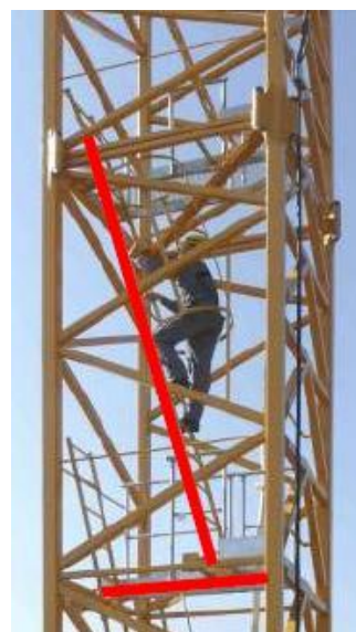
Figura 36: Escada de acesso da grua com inclinação e plataforma de descanso (Liebherr, 2012)
