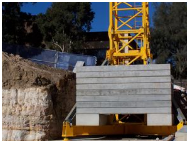
Figura 26: Base fixa de uma guia torre com blocos de betão (Cosmocranes, 2012)
