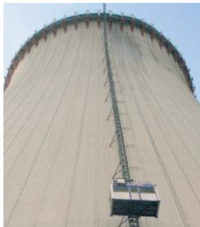
Figura 51: Elevador de obra em operação numa torre de arrefecimento (MetroElevator, 2013)
