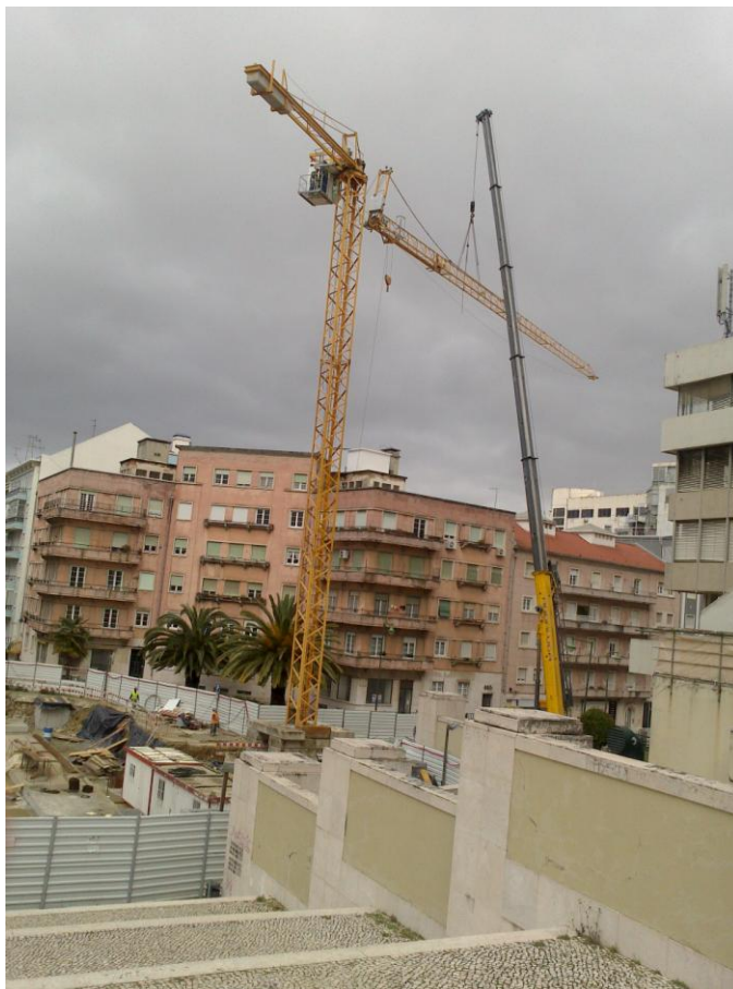
Figura 23: Desmontagem de uma grua torre com recurso à grua móvel
