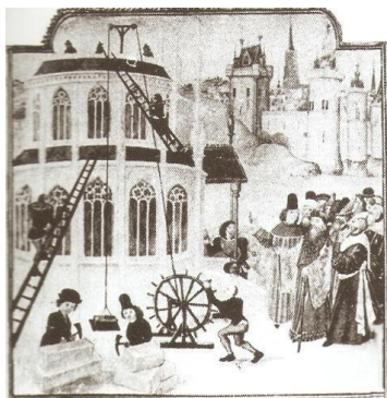
Figura 7: Representação da grua de lança da Idade Média (Bachmann, et al., 1997)
