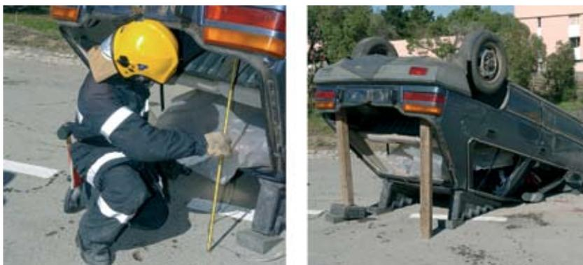
Fig. 92 Evolução da estabilização do veículo.
