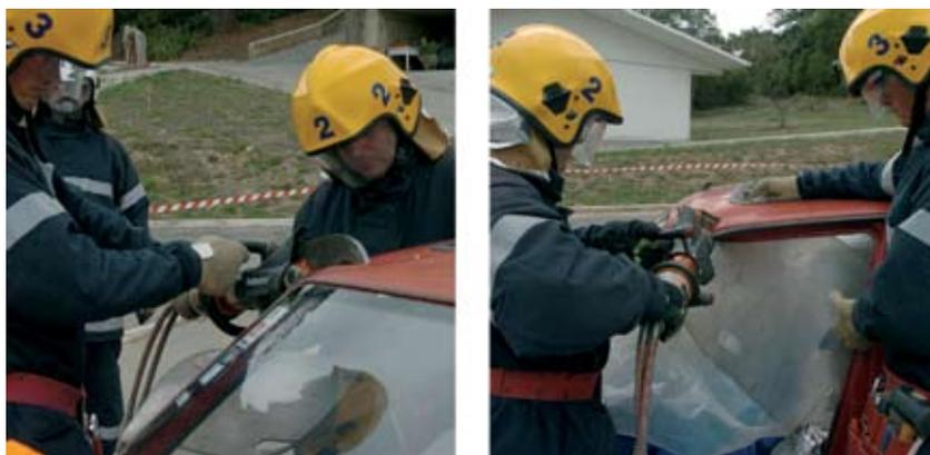
Fig. 69 Cortes parciais no tejadilho junto dos pilares A.
