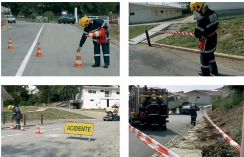
Fig. 6 O isolamento da área de trabalho permite o controlo da situação.
