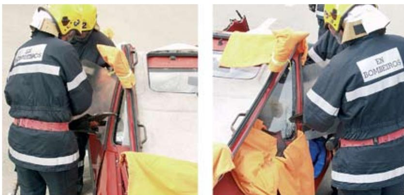
Fig. 75 Cortes nos pontos que fixam o tejadilho.
