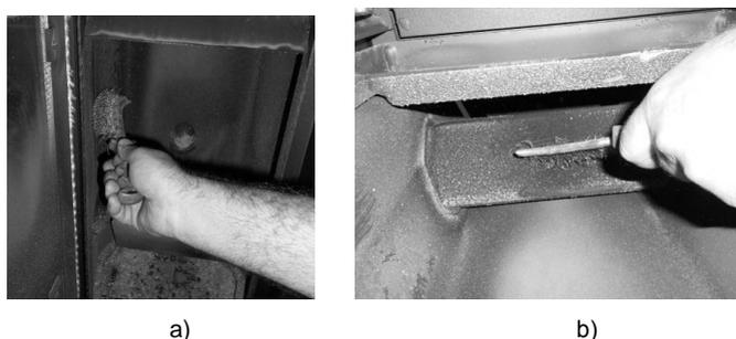
Figura 35 – Limpeza do interior da salamandra a água
