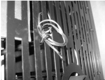
Figura 16 – Sonda de Temperatura Ambiente
