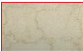
Padrão de manchas causadas por impurezas no vapor condensado
