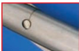
Fissura na região da junção de uma tesoura
