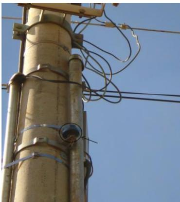
mesmo mecanismo. Enquanto há luz solar, os elétrons são emitidos em um dispositivo chamado **LDR** (resistência dependente da luz), e, que juntamente com o restante dos componentes do circuito, controla o acendimento automático das lâmpadas. Além disso, temos aplicações ao controle remoto, alarmes, abrimento automático de portas. Claro que esses sistemas diferem um pouco um do outro, mas no fundo todos se baseiam nesse efeito.
