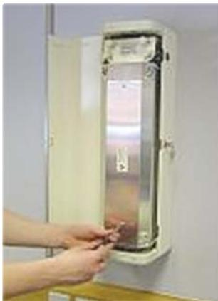
Volte a colocar a tampa da câmara, e reaperte os parafusos um terço. Feche e tranque a tampa .
