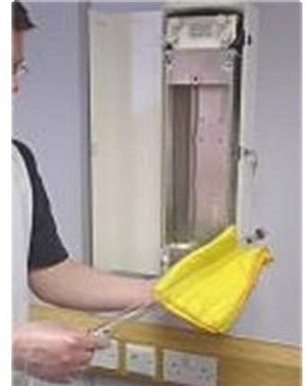
Limpe as lâmpadas com um pano sem fibras antes de as recolocar, ou substitua com novas se necessário.
