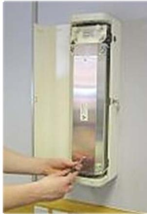
Usando uma chave de fenda, liberte a tampa girando os dois parafusos um quarto de volta
