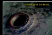
Inspeção de tanque através da câmera Long Focus de 6 mm (VSA2-1)
