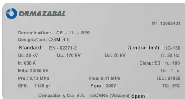
Figura 1.22: detalhe da placa de identificação na cela **cgm.3-l**
