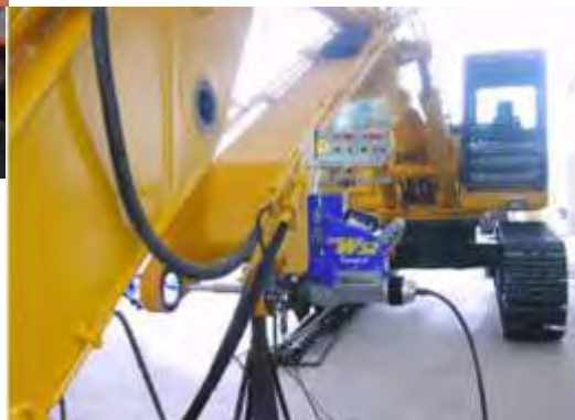
Recondicionamento do braço da escavadora. Intervenção no local, sem necessidade de desmontar a plataforma e os tubos hidráulicos, respeitando o meio ambiente.
