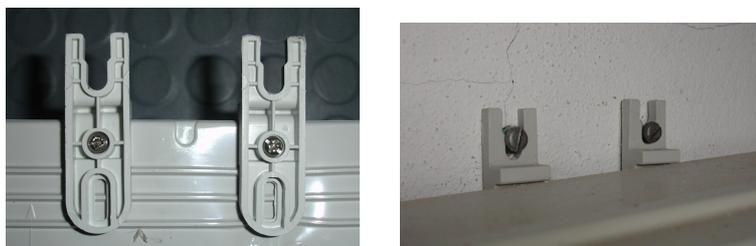
Fixações do Quadro Eléctrico do Hidrion SAL à parede.
