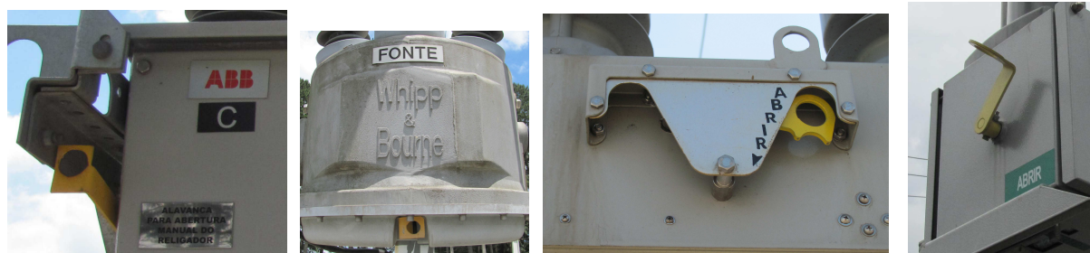
Alavanca de bloqueio mecânico de fechamento do RAU: a) ABB; b) Whipp&Bourne; c) Cooper; d) Arteche.
