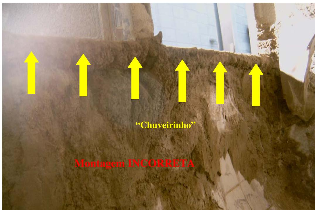
Foto 11 - Vista de "chuveirinho" coberto por excesso de massa de concreto, que prejudica a adição e homogeneização da água na massa de concreto.
