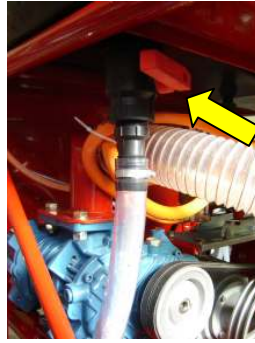
Registro de esfera de esgotamento do tanque fechado.
