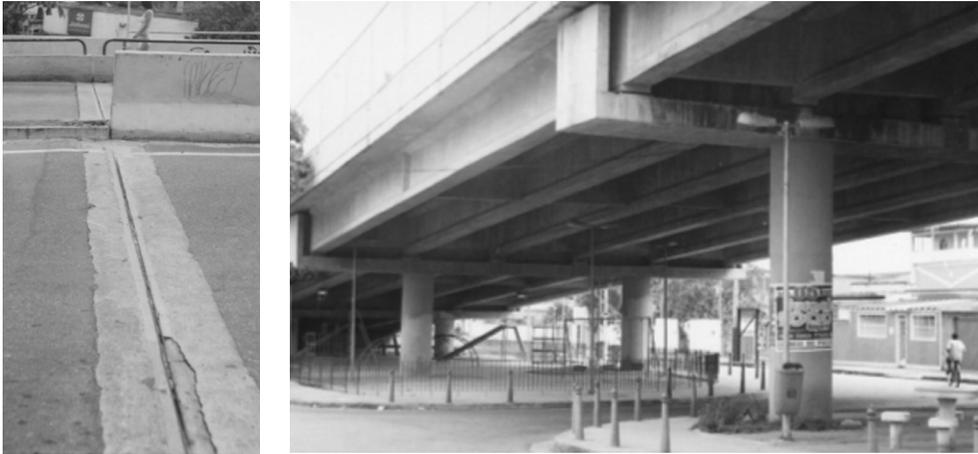
**Figura 9.3:** A fotografia mostra uma junta de dilatação de um viaduto. Esses pequenos espaços entre as partes de uma estrutura servem para permitir a dilatação. Na dilatação, particularmente de sólidos e líquidos, forças poderosas podem ser desenvolvidas capazes de destruir as estruturas mais resistentes. (Fotos obtidas por Marcos André Germano da Silva, aluno do curso de Licenciatura em Física do Instituto de Física da UFRJ.)
