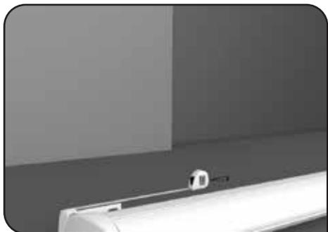
**01** - Coloque os suportes no toldo e fazer uma medição nos limite exterior dos mesmos. (é fundamental que as medidas sejam bem recolhidas de forma a que as furações sejam executadas no local correto.)
