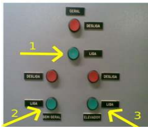
Figura 5 – Sequência correta para testar se o armário está ligado.
