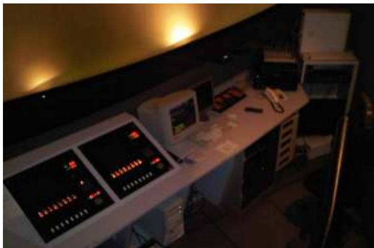
Figura 23 – Mesa de controle da cúpula Carl Sagan, com seus diversos equipamentos.
