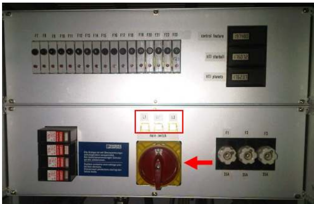
Figura 11 – Seta indicando a chave a ser ligada (sentido horário) e as luzes acima dela (dentro do retângulo vermelho) que acenderão ao girar a chave.
