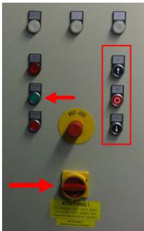
Figura 12 – Indicação da chave que ligará o elevador (abaixo) e da botão verde que deve ser pressionado para que o elevador funcione.
