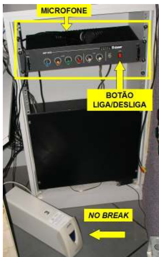
Figura 45 – Sistema sonoro de emergência, ligado a um no break , com a indicação do botão que liga o sistema e da posição do microfone com fio.
