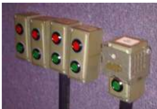
Figura 24 – Iluminação de serviço da cúpula Carl Sagan. O interruptor mais a esquerda é o que ilumina o trajeto do operador até a mesa de controle.
