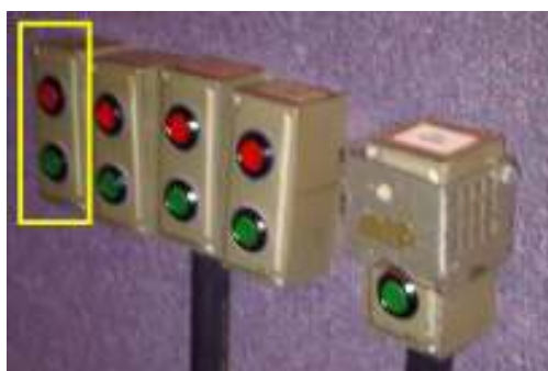
Figura 51 – Indicação do comando que deve ser mantido ligado dentro da cúpula.
