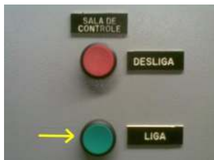
Figura 7 – O botão verde deve ser ligado antes de abrir a porta do armário.
