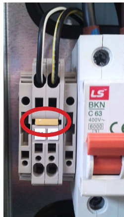
Figura 10: Ponte para realizar o curto-circuito do transformador de corrente (TC).
