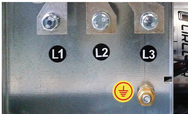
Figura 7: Terminal de terra para conexão a terra exterior das baterias OPTIM EMS-C.
