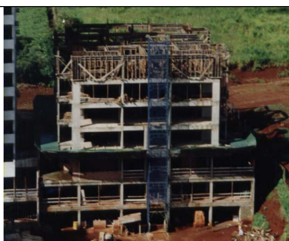
Figura 13 – Confeção de formas sem plataforma secundária
