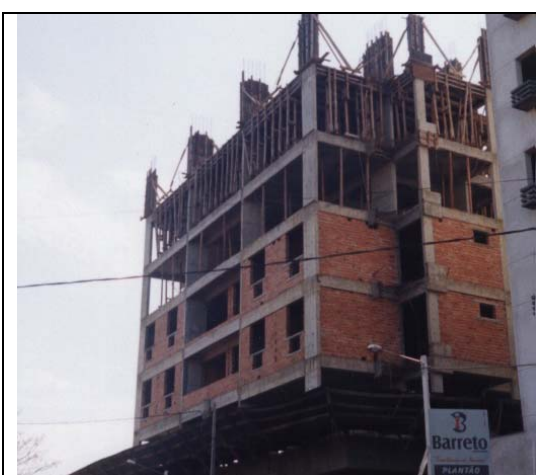
Figura 12 – Elevação de alvenaria sem plataforma secundária
