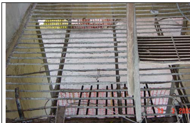
Figura 41 – Fechamento com tela em abertura de piso no poço do elevador
