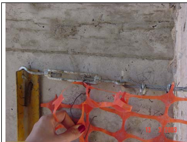
Figura 33 - Fixação da barreira com rede – detalhe da cantoneira metálica
