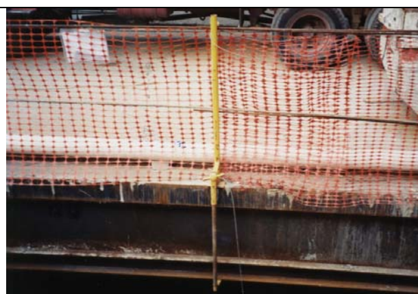
Figura 32 - Fixação da barreira com cabo de aço e rede
