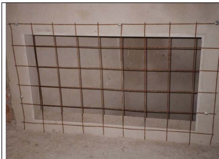
Figura 39 – Abertura de vão em paredes
