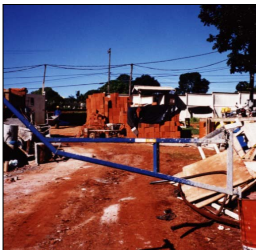
Figura 15 - Viga metálica da Gethal para instalação de plataformas de limitação de quedas de materiais
