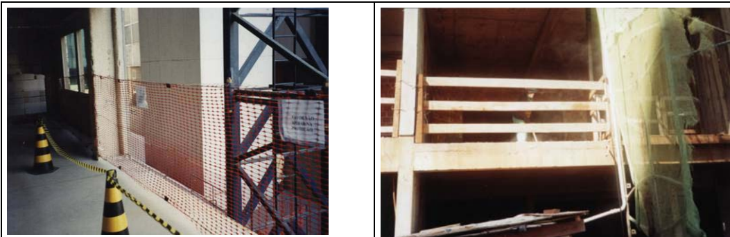
(a) Sistema de barreira com rede
