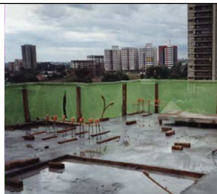
Figura 26 – GcR em madeira e tela
