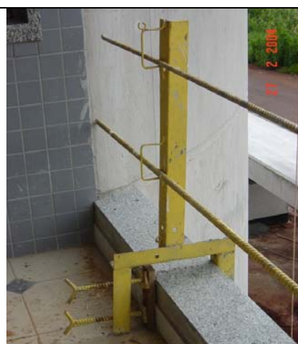
Figura 27 – GcR com montantes metálicos
