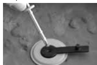
Remova o pino depois que o concreto tiver endurecido
